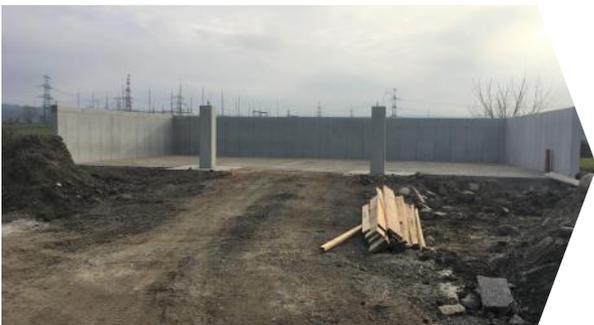
Der Bau der neuen Streuguthalle bei der Kläranlage schreitet voran. Die Betonarbeiten sind bald fertig gestellt, dann kann die Halle darauf errichtet werden.
