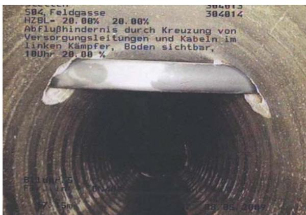
Kabelrohr durch Kanal
