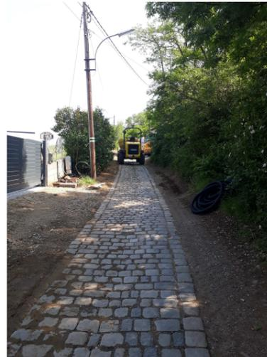
Bautätigkeit in der Hundsleiten. Hier werden die Oberleitungen der EVN in den Boden verlegt. Wir bitten die Unannehmlichkeiten während der Bauphase zu entschuldigen.
